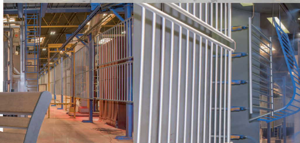
Ligne automatisée de thermolaquage
